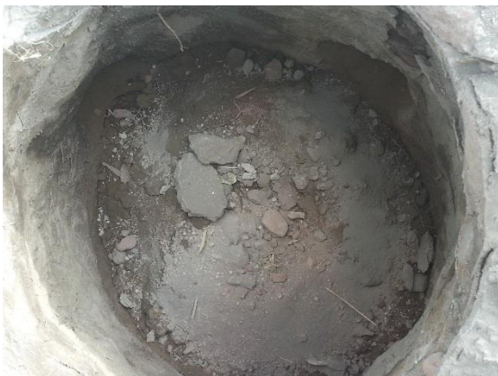
FOTO Nos. 19 y 20: POZOS LLENOS DE ESCOMBROS Y TIERRA.
