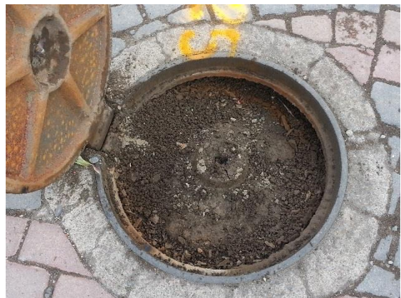
FOTO Nos. 19 y 20: POZOS LLENOS DE ESCOMBROS Y TIERRA.
