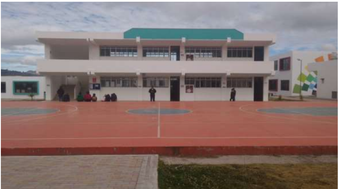
Foto N°.60: Infraestructura educativa 1 de la parroquia Palmira del cantón Guamote
