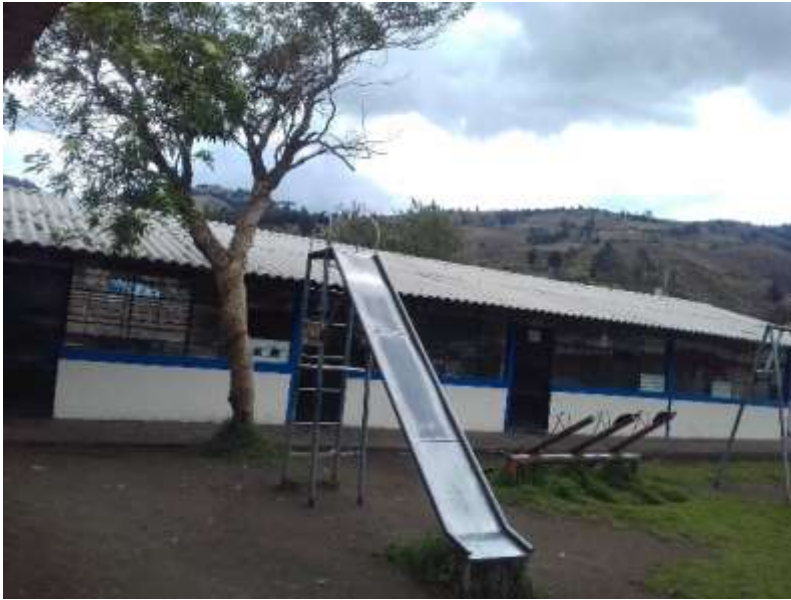
Foto N°.51: Infraestructura educativa 3 de la parroquia Cebadas del cantón Guamote
