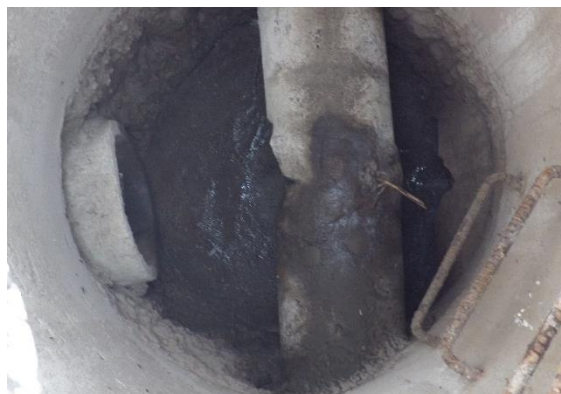
FOTO No. 11.- ESTADO ACTUAL DE LAS TUBERÍAS
