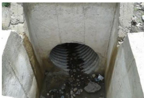
FOTO No. 21.- ALCANTARILLA PASO DE CALLE PÚBLICA
