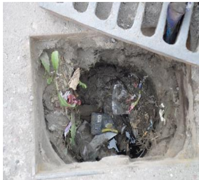
FOTO No. 5.- REJILLAS TAPONADAS Y COLAPSADAS
