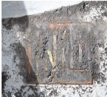
FOTO No. 5.- REJILLAS TAPONADAS Y COLAPSADAS
