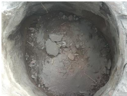
FOTO No. 8.- TUBERIA Y POZO COLAPSADOS
