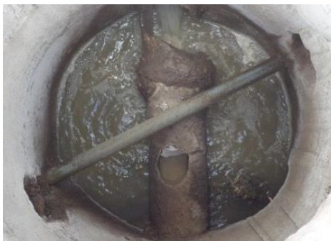
FOTO No. 8.- TUBERIA Y POZO COLAPSADOS
