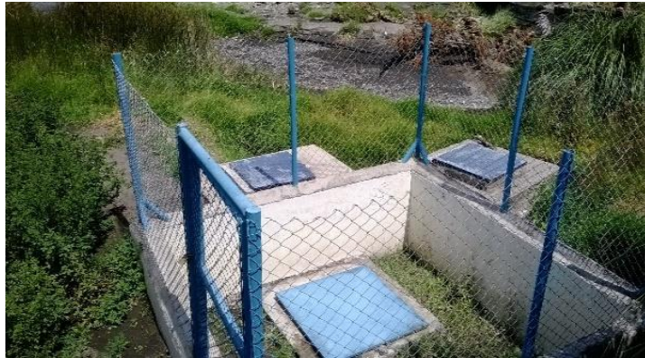
FOTOS N° 6 CERRAMIENTO CAPTACIÓN CHIPO CHICO
