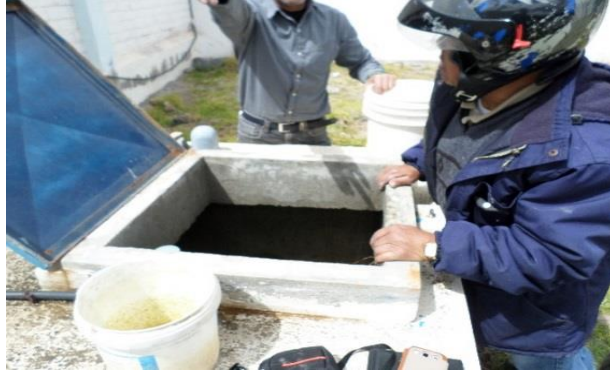
FOTOS N° 12 INGRESO DE CAUDALES AMBATO POGIO Y CHIPO CHICO AL TANQUE
