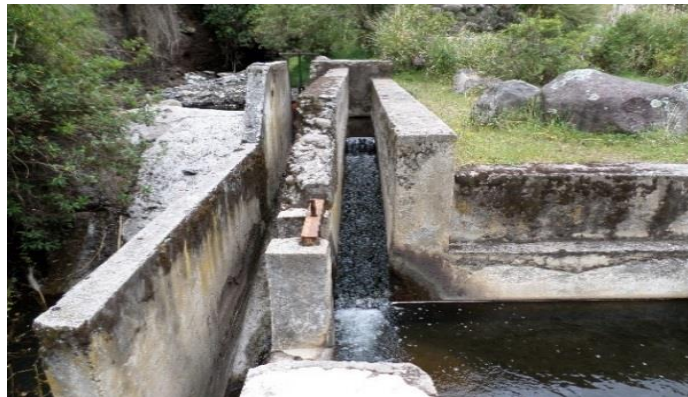
FOTOS N° 4 ALIVIADERO CAPTACIÓN MATIPANGA
