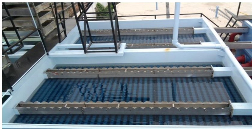
FIGURA N° 7.- DETALLE DEL SEDIMENTADOR DE ALTA TASA
