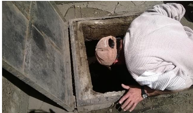
FOTOS N° 8 CAPTACION AMBATO POGIO
