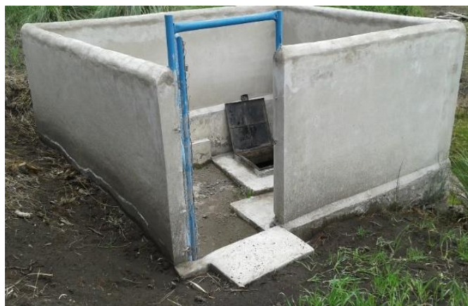
FOTOS N° 9 CERRAMIENTO CAPTACIÓN AMBATO POGIO
