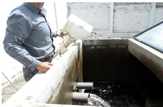
FOTOS N° 11 INGRESO DE CAUDALES MATIPANGA AL FILTRO
