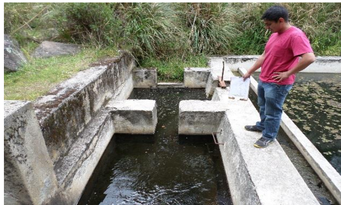
FOTOS N° 5 VERTEDERO CAPTACIÓN MATIPANGA
