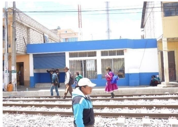
CAH Foto No.14: Instalaciones de CNT en el cantón Guamote
