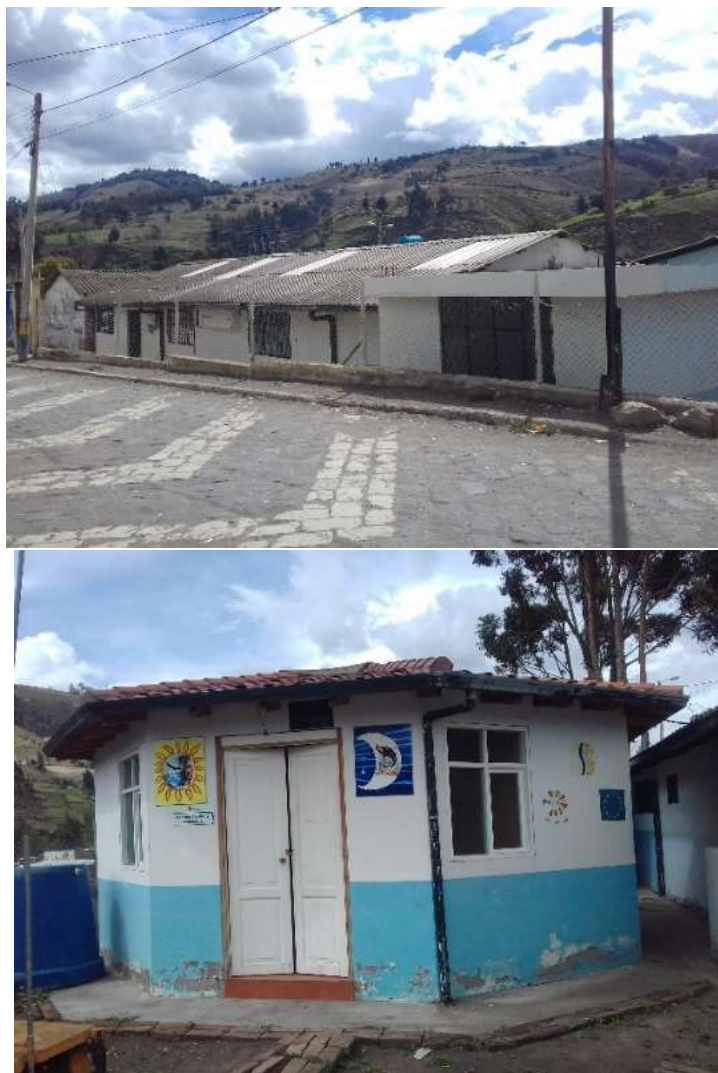
Foto N°.54: Infraestructura de salud 1 de la parroquia Cebadas del cantón Guamote
